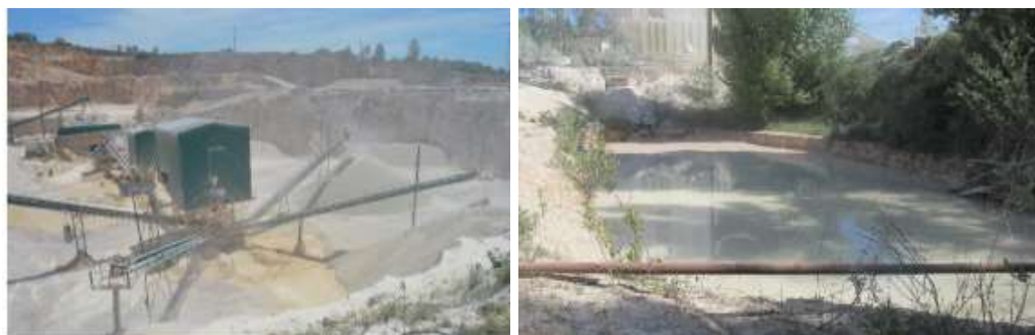
Figura III.27 – Unidade de britagem e bacia de decantação de finos existente na pedreira.
