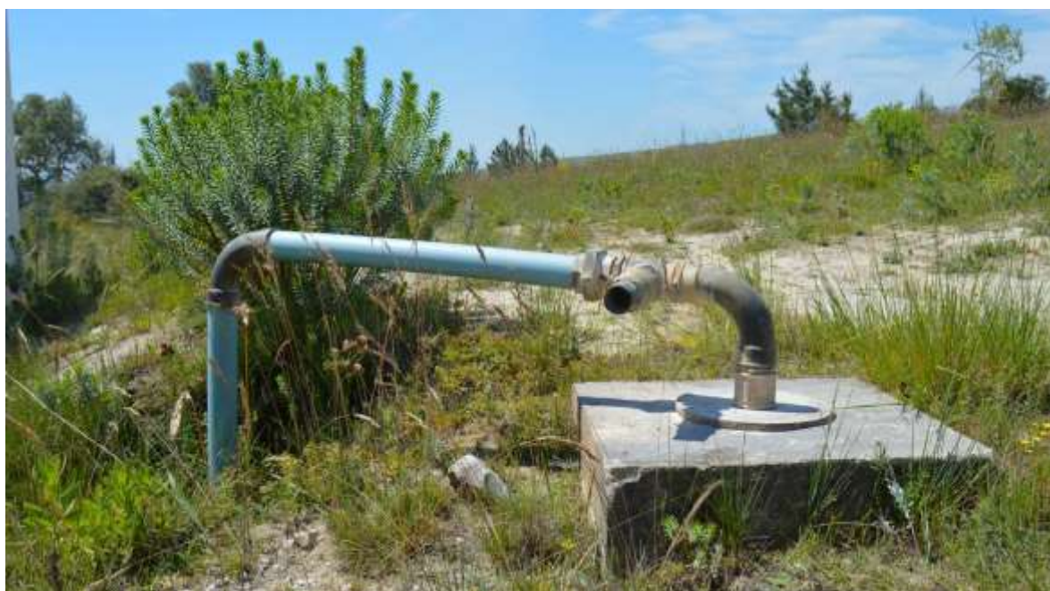
Figura III.24 – Furo vertical que abastece a pedreira.
